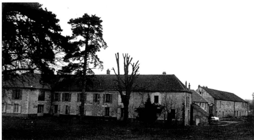
La Ferme de Bois-Briard en 1978 (ADE 2 W 35). À gauche, le logis seigneurial et celui du fermier et ce qui reste du jardin d'agrément, à droite l'entrée principale.
